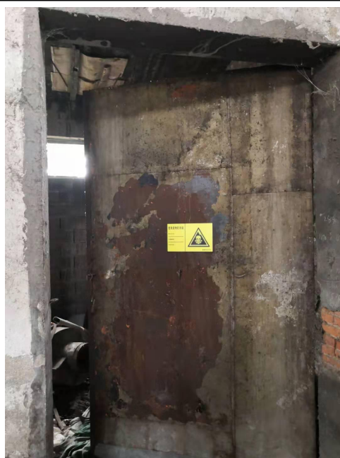
危险废弃物储存
