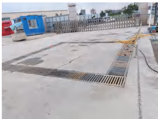
项目入口处洗车池
