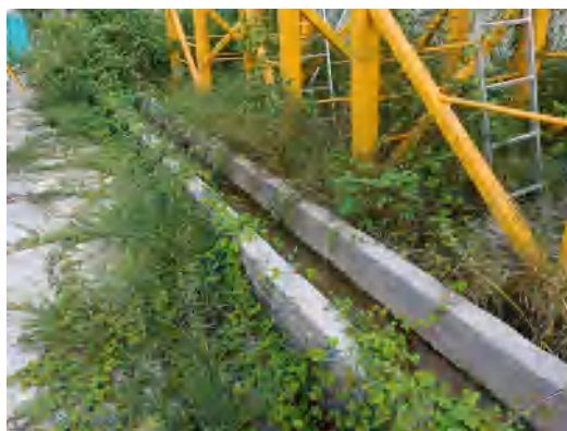
项目区排水沟
