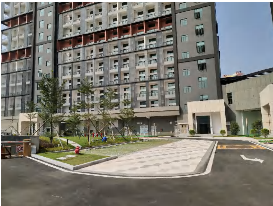
施工结束后场地情况
