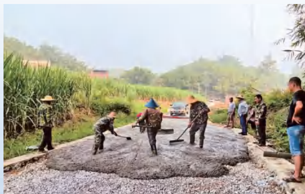
产业路施工现场
