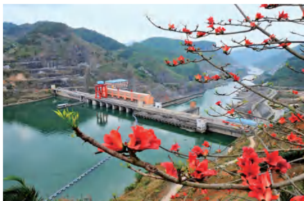
桂冠电力岩滩水电站
