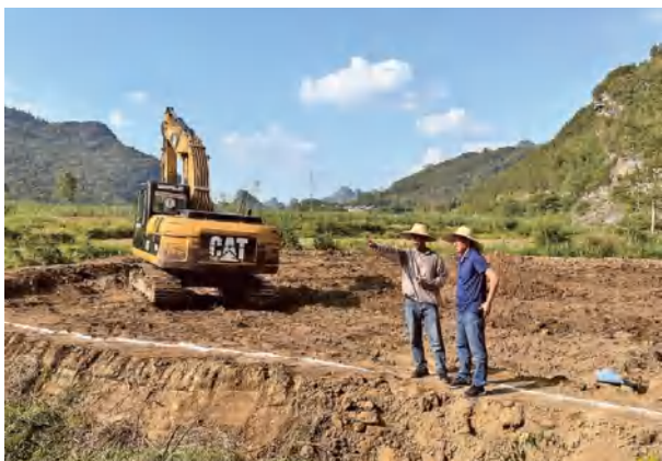
田东县印茶镇立新村项目施工现场
