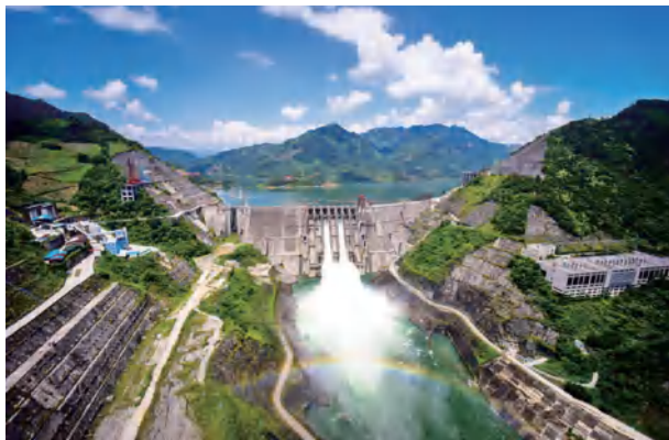
广西最大水电工程——龙滩水电工程
