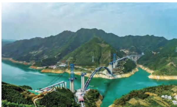
2023年4月底，完成外包混凝土施工
