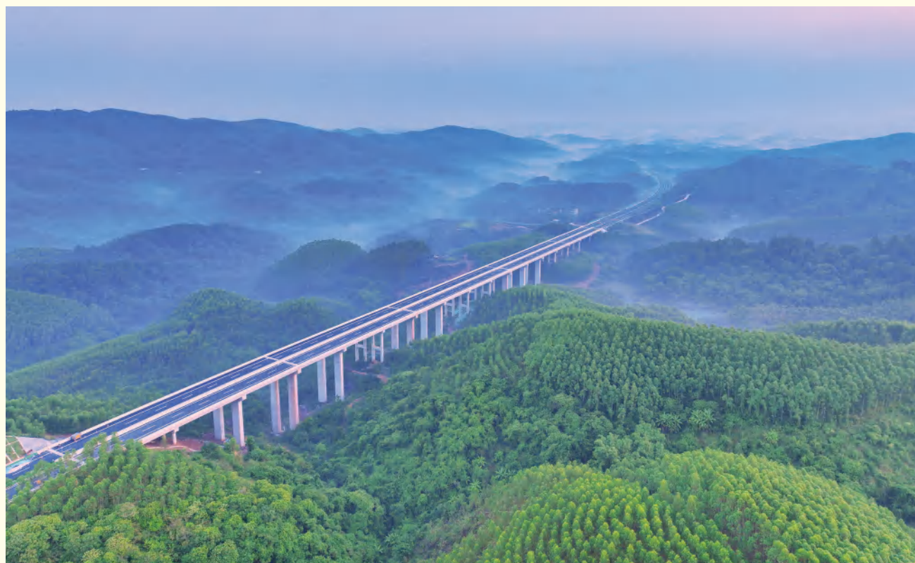
吴上高速一期工程六林大桥（罗芸婕 摄）
