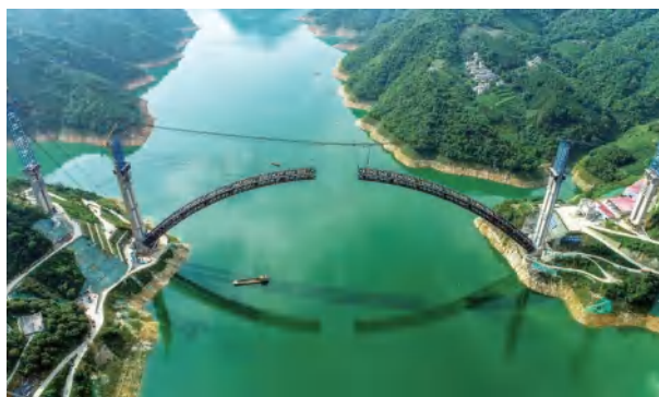
大桥拱肋高精度合龙，犹如在百米高空“穿针引线”
