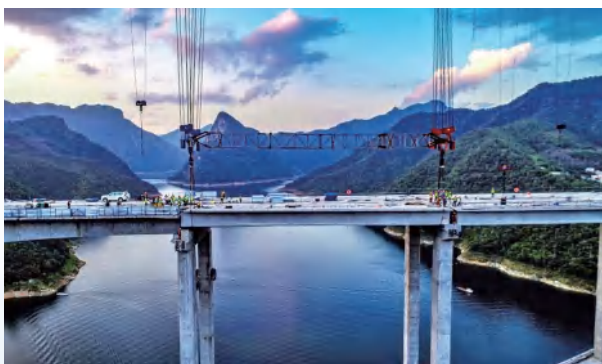
2023年4月底，完成外包混凝土施工
