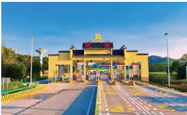
吴上高速一期工程延安收费站
