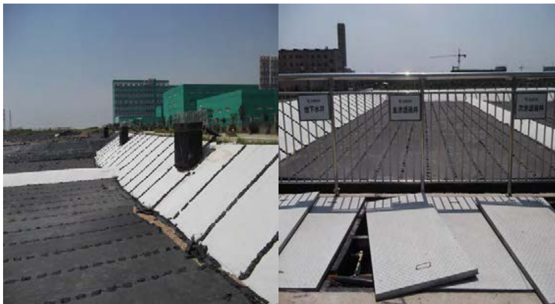
图 4-17 地下水收集及导排系统
