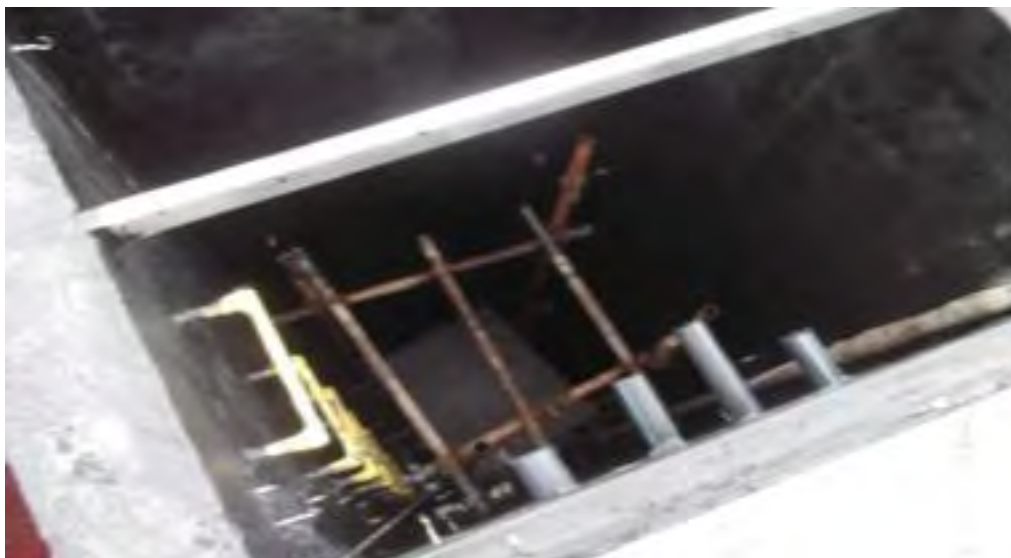
图 4-10 渗滤液收集池
