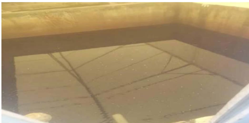
图 4-3 污水处理设施出口
