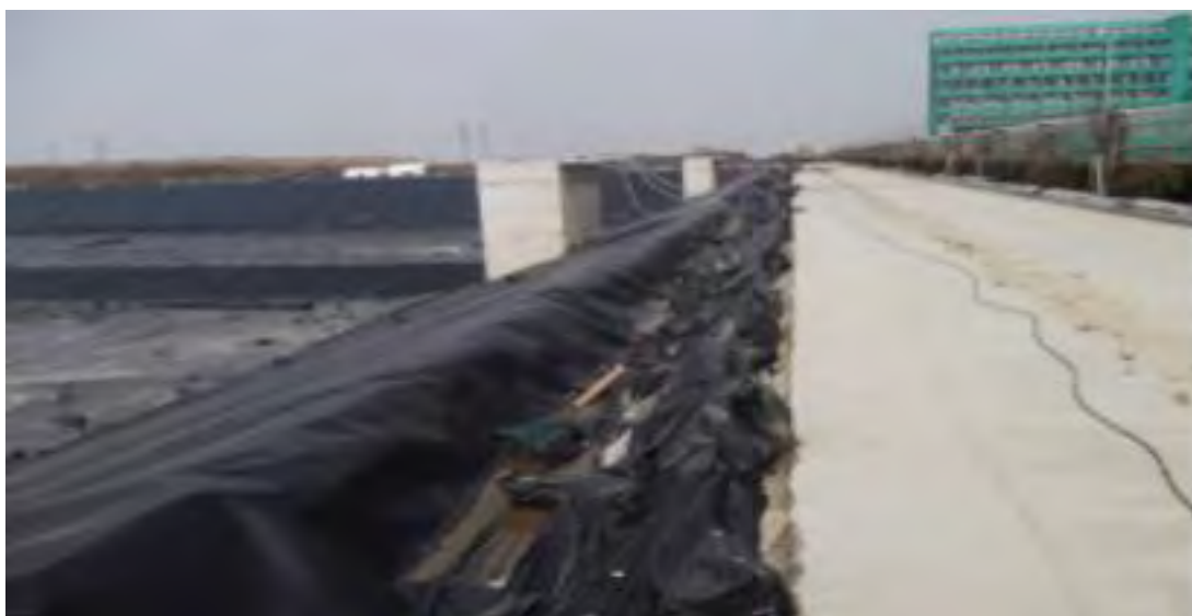
图 4-7 施工防渗水措施
