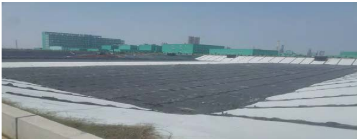
图 4-13 一般性固体废物填埋场
