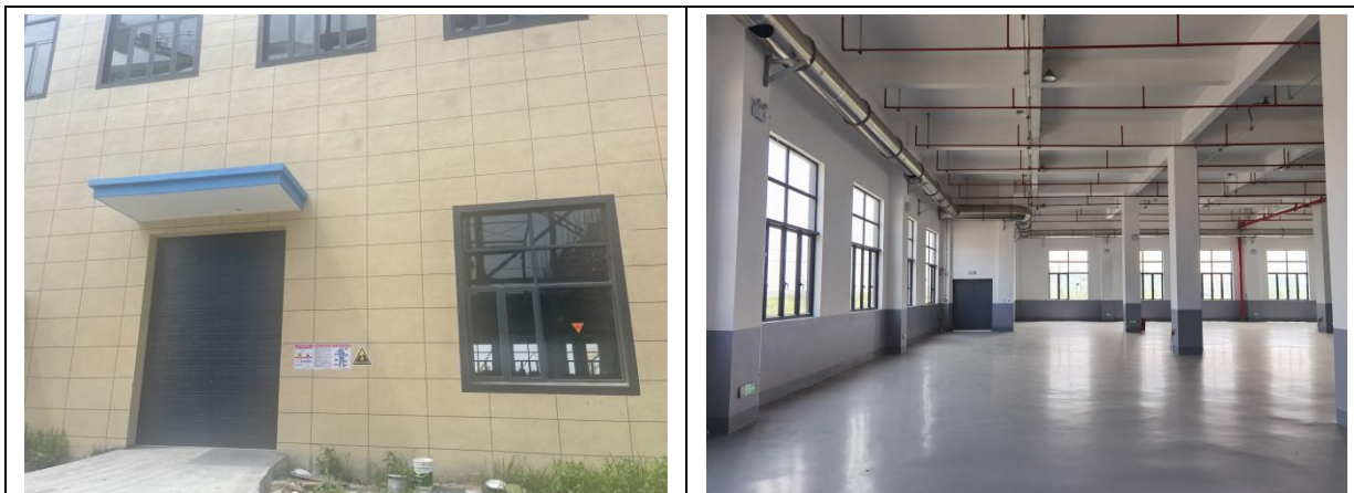
图 4.1-5 危废暂存库照片
