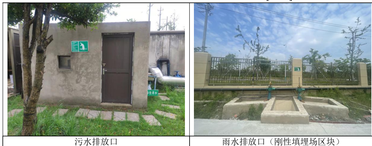
图 4.2-2 企业污水排放口及雨水排放口
