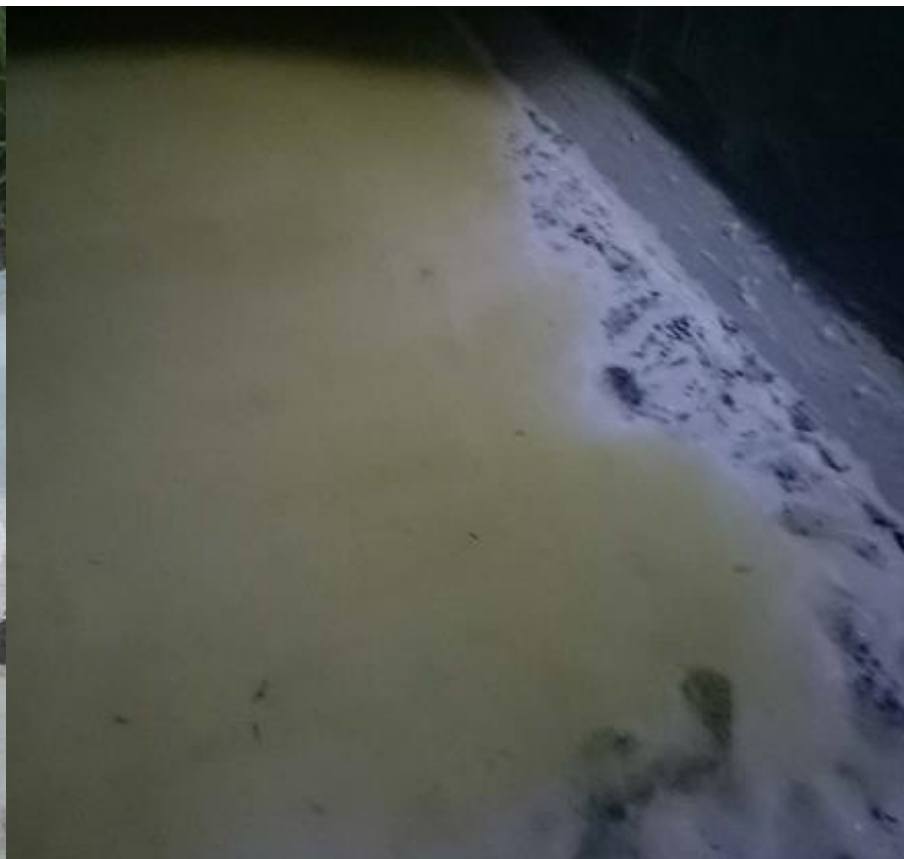
混盐DTRO进水池沉积物（纳滤浓缩池）。
