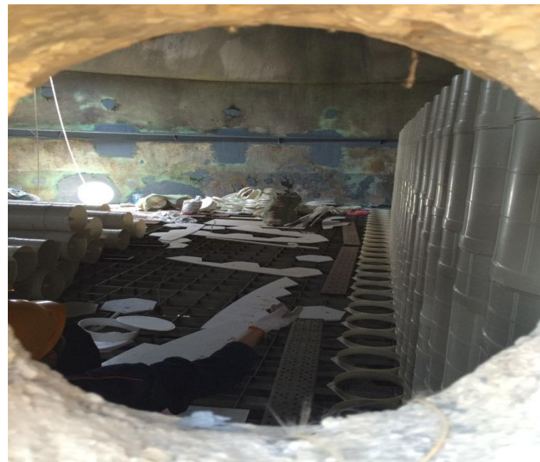
管束式除尘器安装
