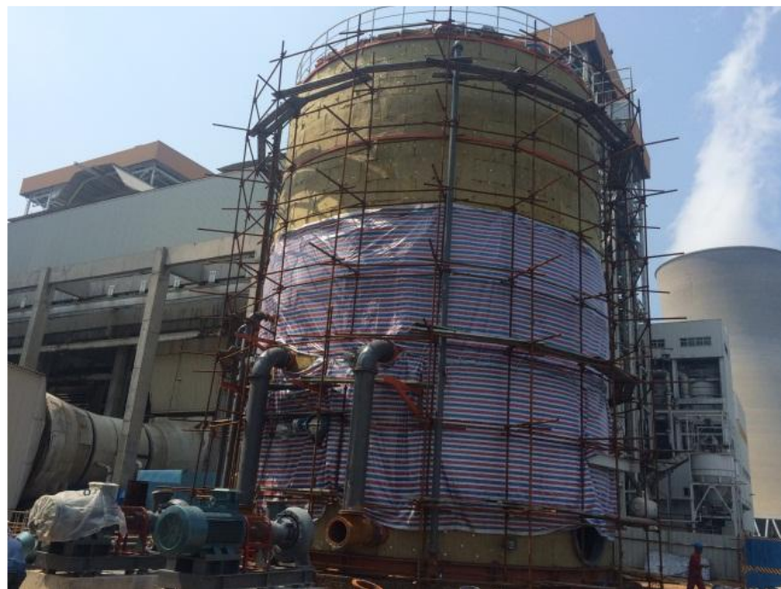
新浆液澄清箱安装
