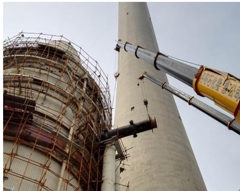
喷淋层母管更换
