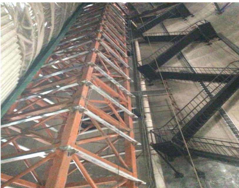
烟囱CEMS测点电梯钢架安装
