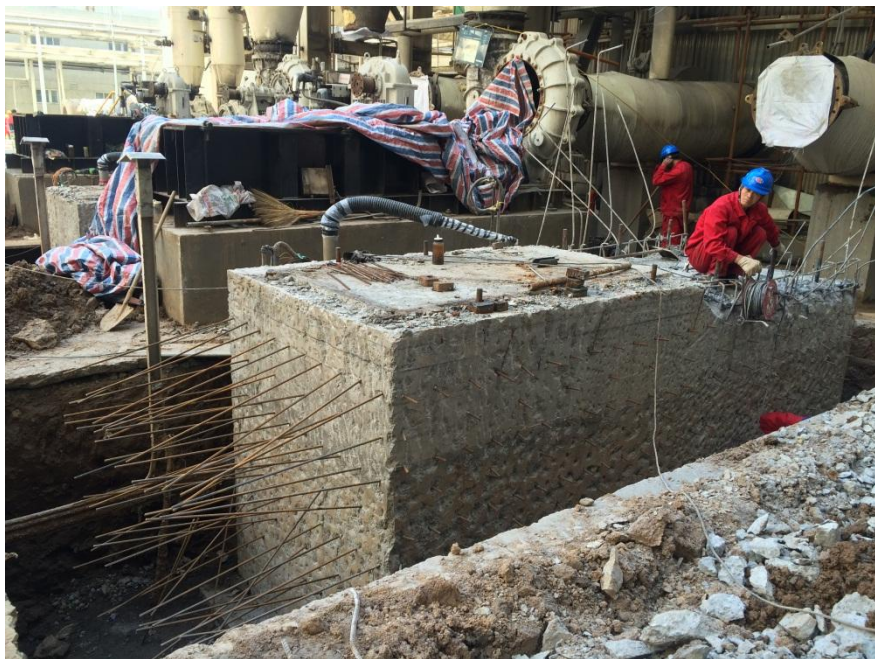
新浆液泵基础改造
