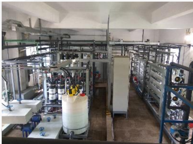
华能玉环电厂示范项目超滤-反渗透-脱气膜系统
