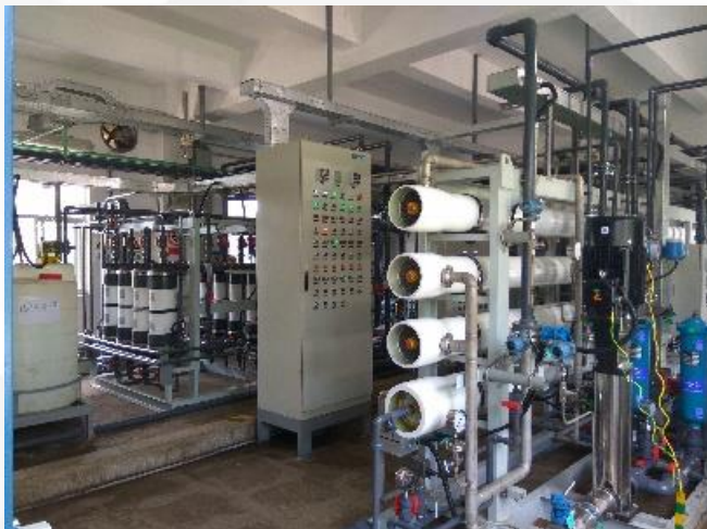
华能玉环电厂示范项目超滤-反渗透-脱气膜系统
