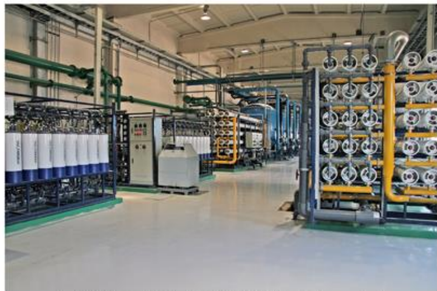
化学水处理系统在全国首次使用反渗透+EDI技术
