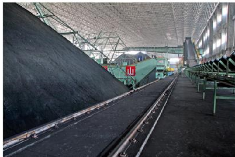
建筑面积12600平方米，存煤6万吨的全国最大的全封闭式配煤场
