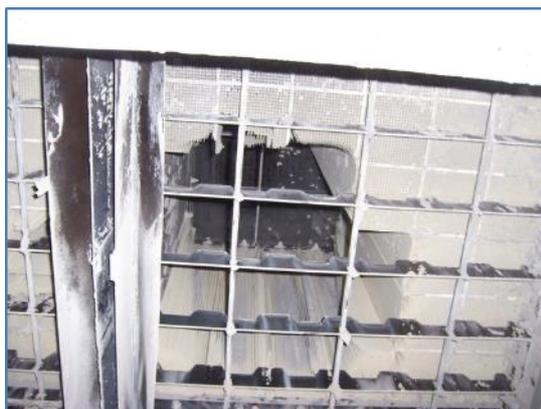
图 1 某蜂窝式催化剂磨损后坍塌
