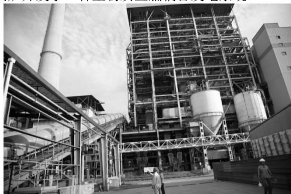
图4 流化床锅炉固废及生物质耦合发电项目实景
