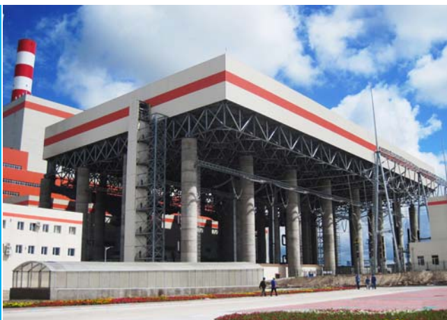
机械通风直接空冷系统
