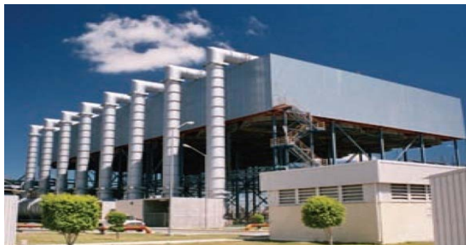
机械通风直冷系统ACC
