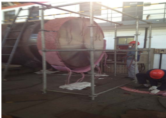
焊接及热处理
