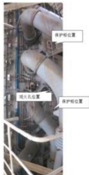
6套煤质辨识测枪分别安装在A~F层2号角或4号角的观火孔处
