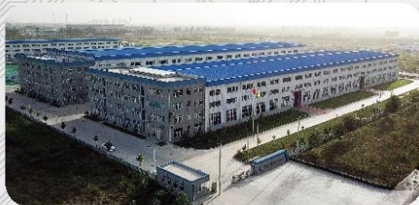
华源泰盟北京工业园区
