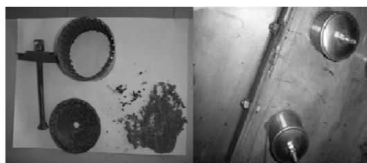
滤网解体后里面有铁屑
