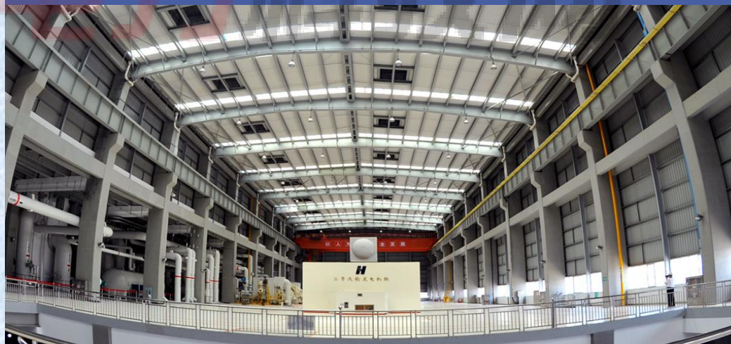
海门电厂汽机房
