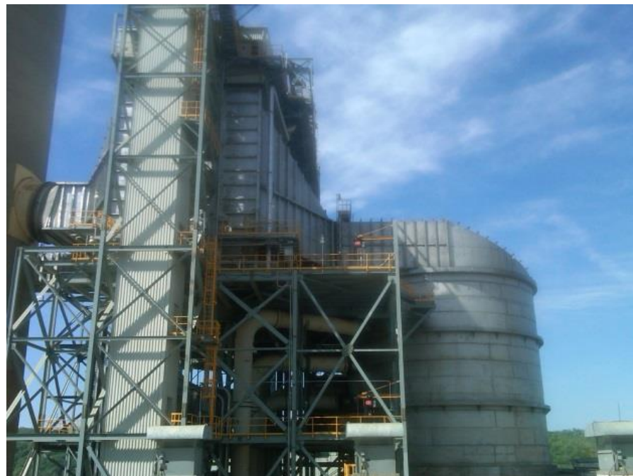
美国Trimble County 电厂 — 820 MW 水平喷淋板式湿式电除尘 器
