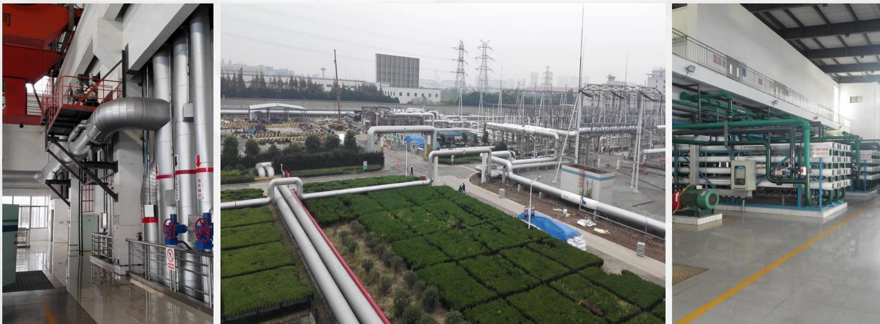
苏龙公司深入开展厂内供热改造，目前一期、二期机组从高再热段抽汽输出至供热分汽缸，由中压调门配合调节。三期机组从高再热段抽汽输出至供热分汽缸，由中压调门配合调节；同时可从高排抽汽经减温减压后各自接至供热分汽缸。经过设备改造，苏龙公司6台机组通过分汽缸互连互通，划分不同压力等级供热工况适配区域用汽需求，形成1420t/h的供汽能力。
