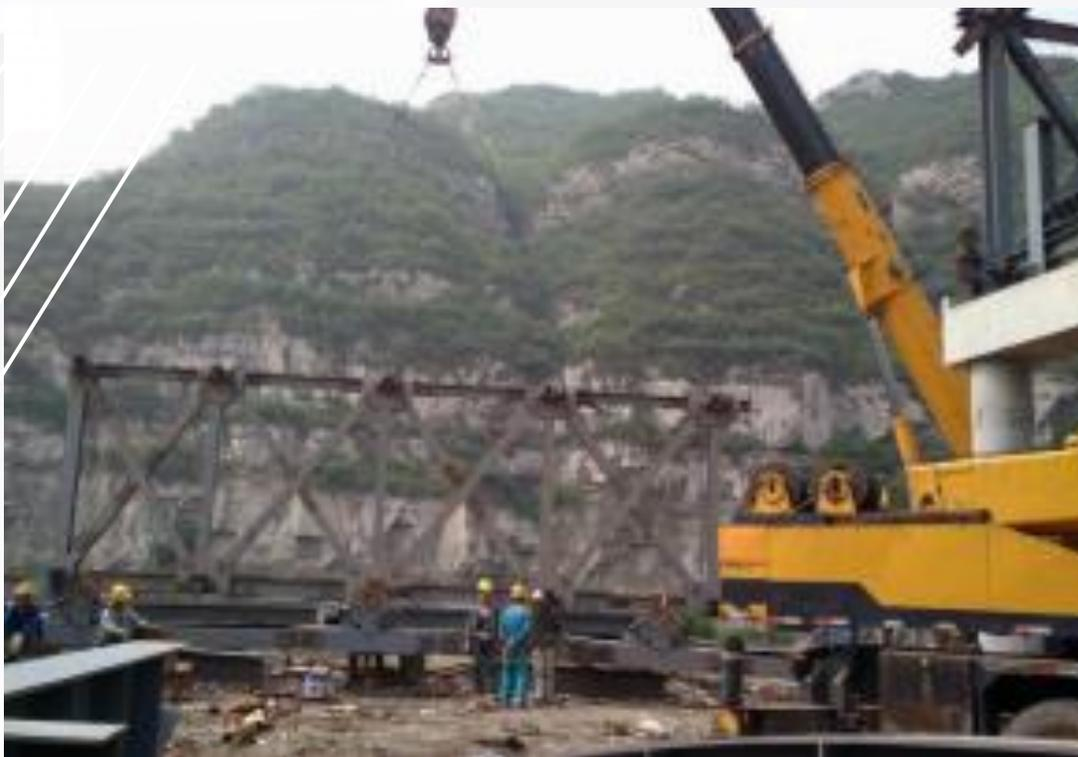
卧拼完成后，利用大型吊车（350t）进行平转立。关键是钢桁梁侧弦的平、立面位置要准确定位，在水平面上，要求侧弦准确对位事先在台架上设好的标线，在立面上，校定侧弦的垂直度满足安装要求，再进行下弦鱼腹梁及上弦大梁安装，组成钢桁梁。
