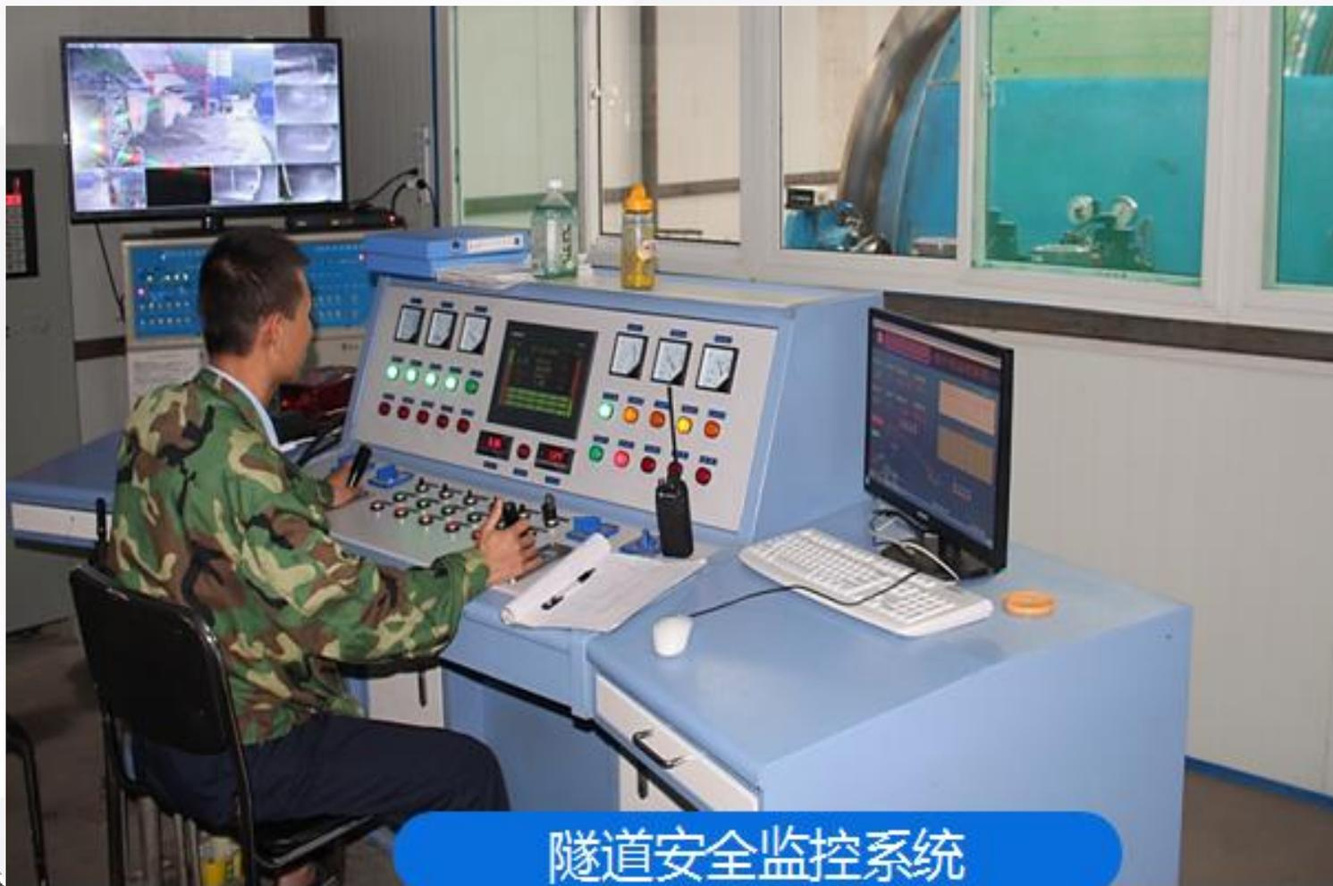
提升设备在斜井内运行的监控系统采用全程摄像头监控，每隔100m设置1个监控摄像头，监控整个运输过程，一旦线路某个部位或运输过程出现问题，通过监控器能够及时发现，立即采取制动措施停车，排除故障，有效的保证了运输过程的安全。
