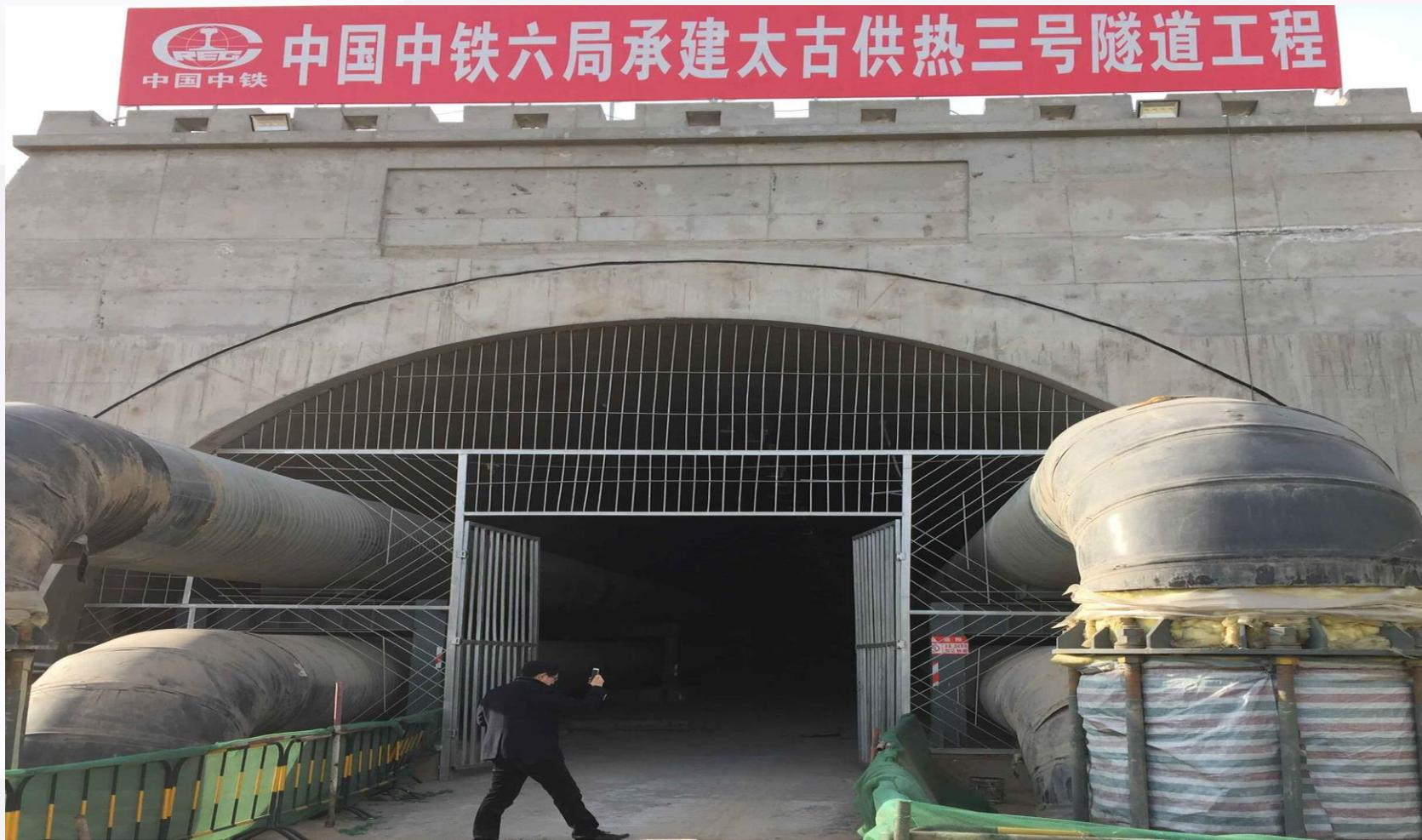
隧道最长一座为11.04km，隧道主洞净宽10.25米，净高5.0米，通风道加宽13.0米，设计等级按照公路一级标准设计。
