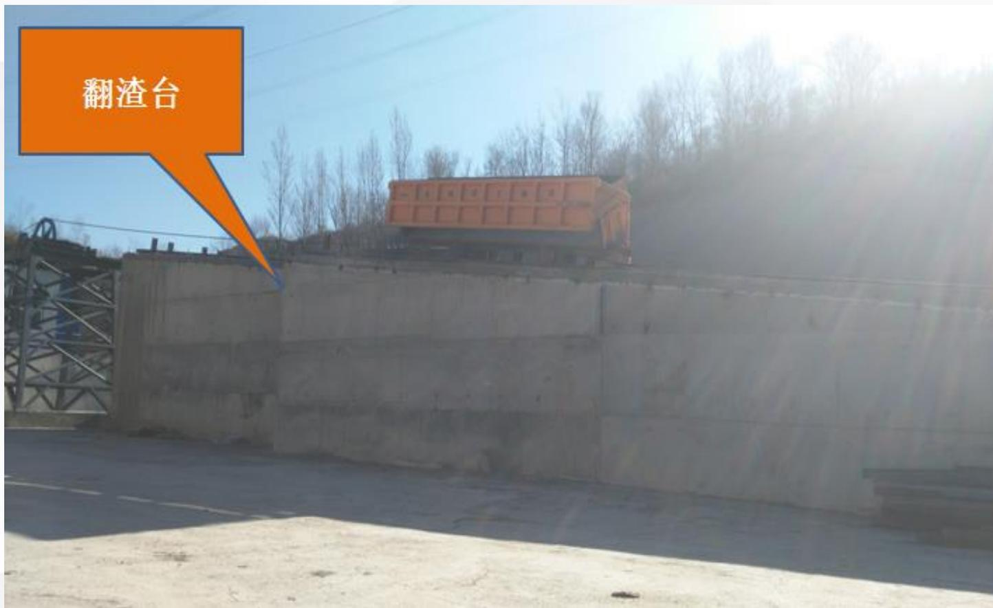
根据提升机的提升能力，通过洞口2次变坡后设置符合规范要求的“L”型卸渣台。单卷筒提升机为材料运输，双卷筒提升为出渣运输，通过“L”型设计，卸渣台可同时满足两条运输线同时运输。
