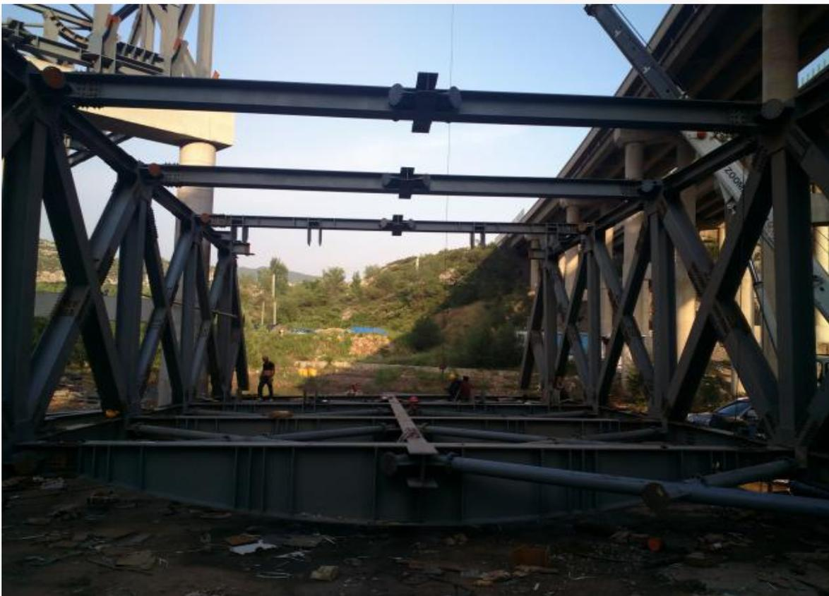
平转立后，大吊车移走，配置1-2台25t汽车吊，完成剩余构件的安装。
