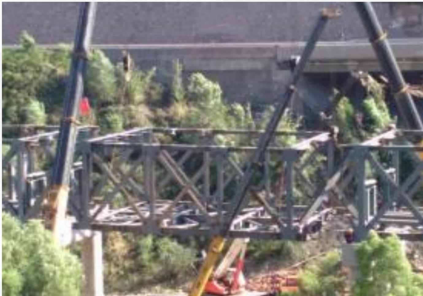
首先对前期预拼的桁架严格控制精度，每一段桁架都必须在误差允许范围内，吊装的桁架必须准确就位，严格按照测设的位置就位。其次在龙口桁架预计安装温度条件下多次准确测量预留龙口的跨度，在地面拼装时根据实际测量的尺寸进行拼装。
