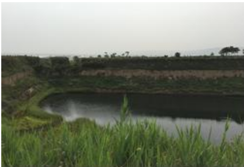
YC事故水池
