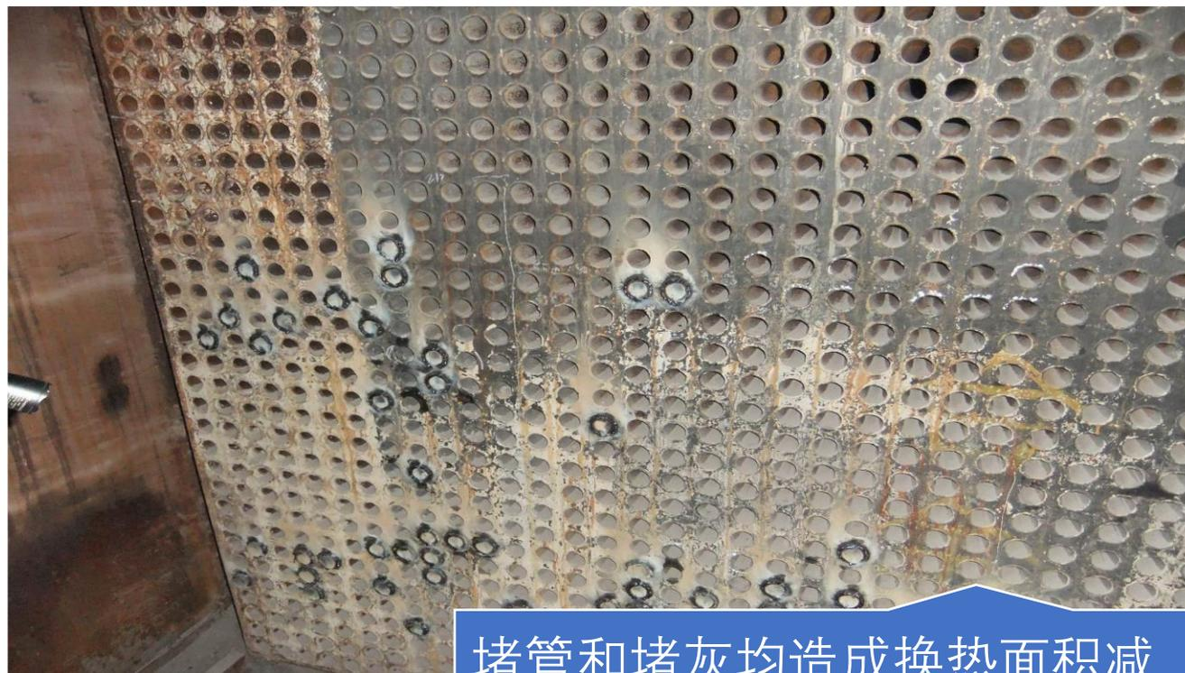
堵管和堵灰均造成换热面积减少，换热效果变差，导致排烟温度升高，锅炉效率降低。
