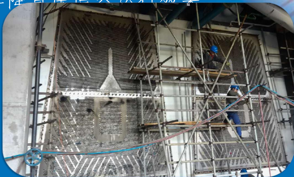
图3 凝汽器更换内部结构
