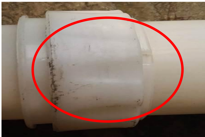
新管托帽安装部位管身加有止退槽
