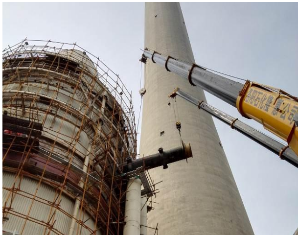
旧喷淋层母管拆除
