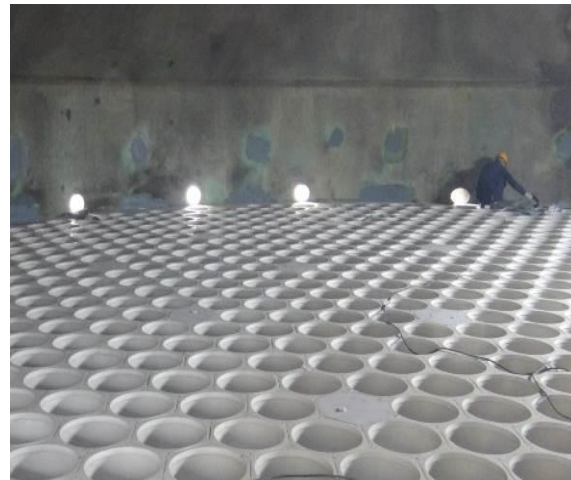
管束式除尘器安装
