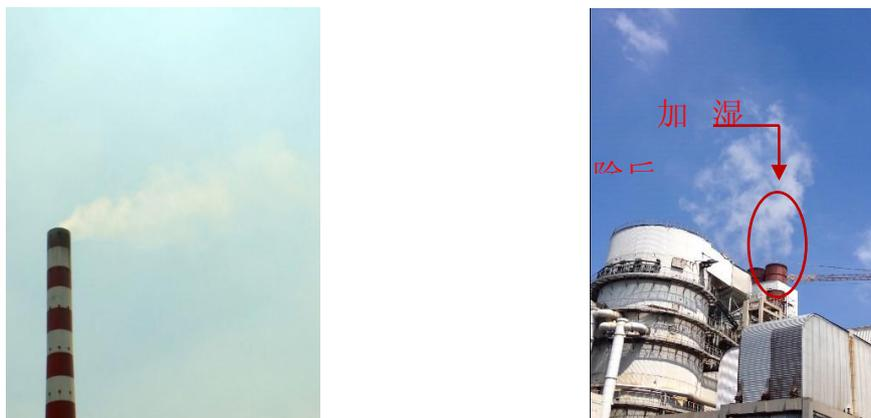
(a)、#1机负荷580MW工况(无湿除) (b)、#2机负荷600MW工况(投湿除)
