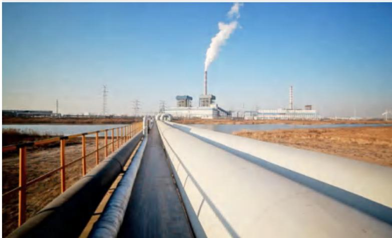
▼ 山东东营兴达新能源有限公司2×C150MW+1×B60MW热电联产工程，采用高背压低真空供热，换热首站设计供暖面积1000万m<sup>2</sup>，供回水温度100/65℃。
