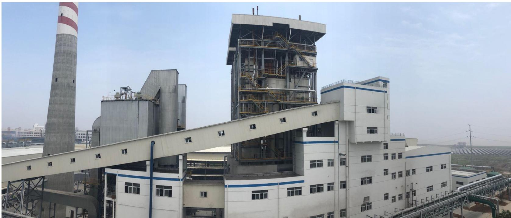
世界首台纯燃一般工业固废的循环流化床锅炉
