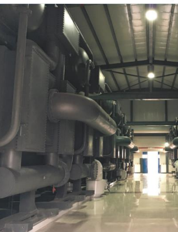
#1机热泵改造现场图
