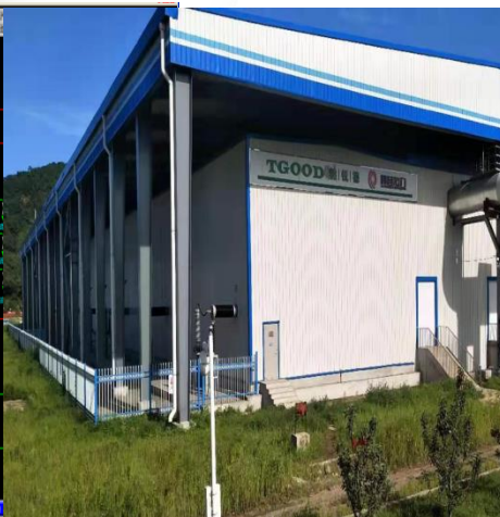
电蓄热锅炉房
