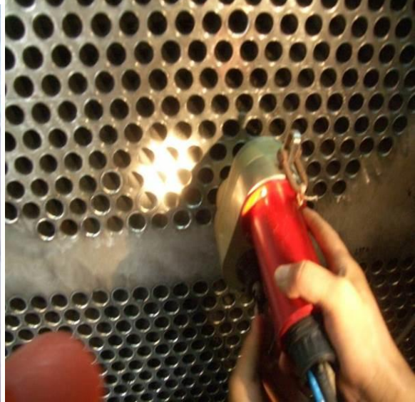
图11-4 焊接凝汽器冷却水管端口
