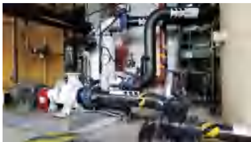
凝汽器在线胶球清洗倍增系统
