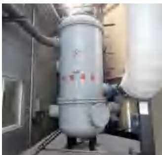
脱硫浆液余热利用装置
