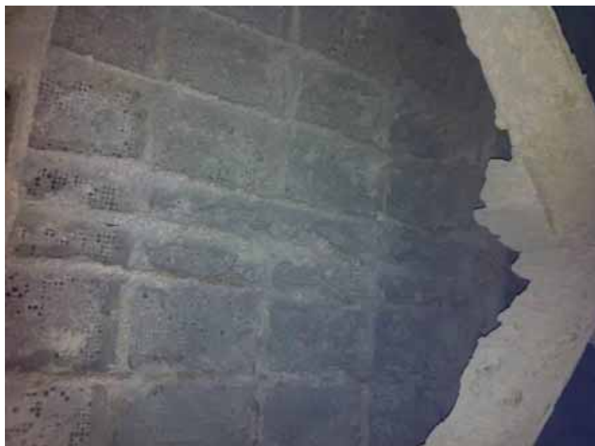
图 7 腐蚀严重
