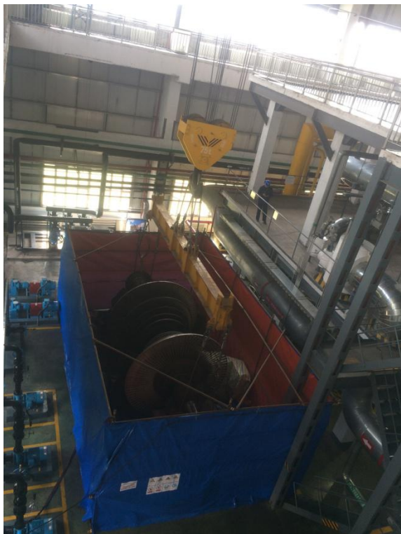
国电延吉电厂#2机切缸现场施工图
