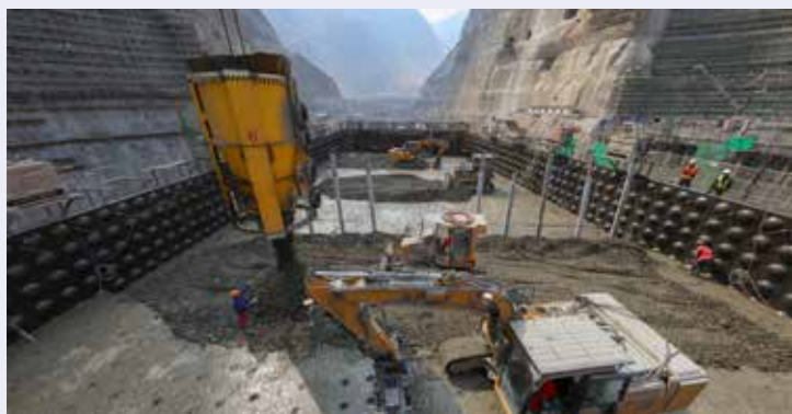
低热水泥混凝土施工现场
