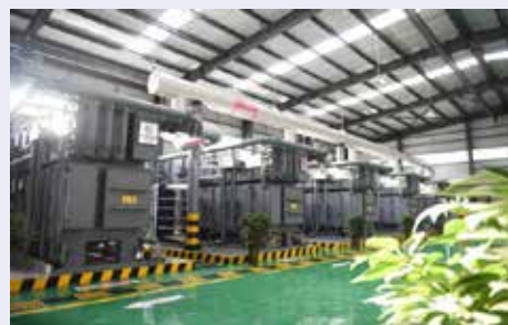
先进的热泵机组，供水温度130℃，回水低至30℃
