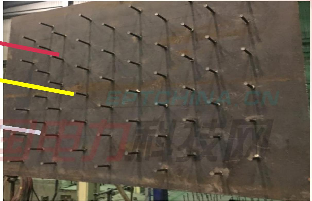
外包钢板与新增基座柱采用栓钉连接
