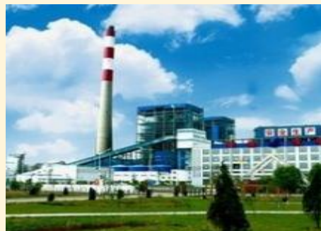
山西武乡电厂 2×600MW
