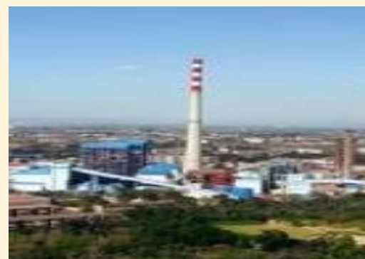
唐山丰润电厂 2×300MW
