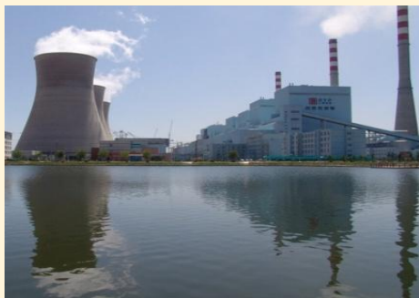
内蒙古托克托电厂 8×600MW
