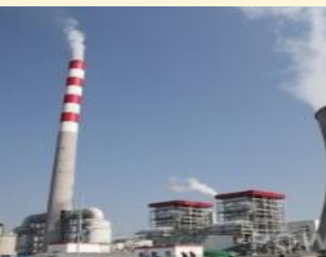
重庆石柱电厂 2×350MW
