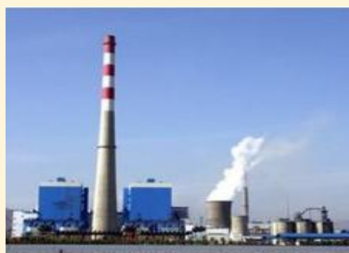
山西大同电厂 2×220MW 2×320MW
