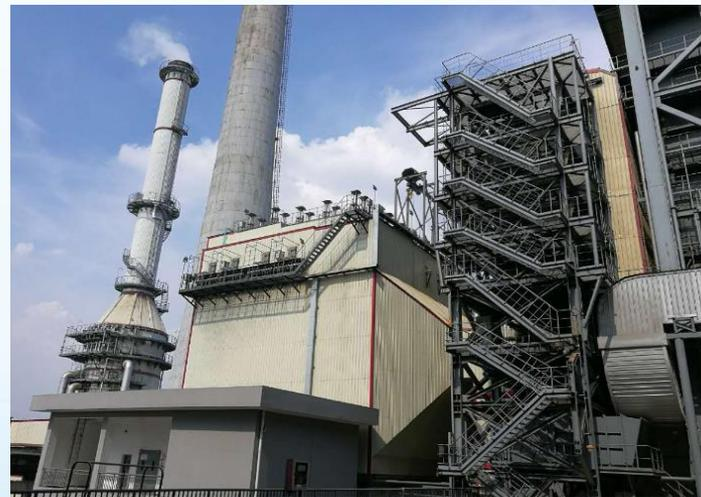
锅炉配套上海空预器厂有限公司生产的 $\Phi 6700\text{mm}$ 回转式空预器。空预器运行至今经历**增加分仓、密封系统改进、吹灰器喷嘴更换、冷段传热元件更换为搪瓷波形板、安装中压冲洗水系统等改造**。使用过程中发生过不同程度的漏风、堵塞、吹损、腐蚀问题，经过处理基本恢复正常。
