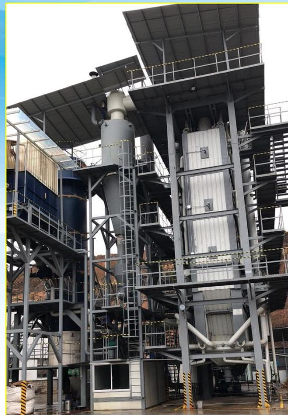
浙江丽水生物质气化供8t蒸汽锅炉联产炭项目 (竹屑)
