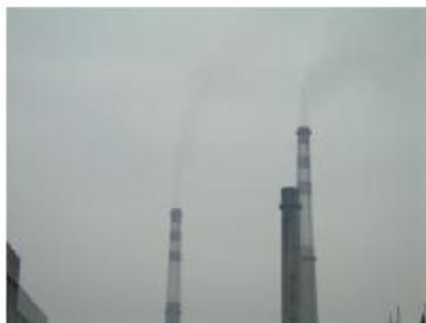
韶关电厂安装湿法脱硫后的黄色烟羽
