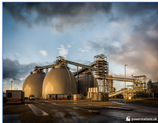
大型生物质颗粒燃料防火储仓及密封防火输送系统，每仓容量为75000吨
