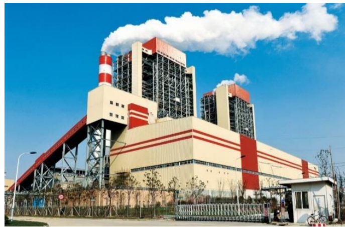
上海外高桥电厂三期工程2×1000MW机组
