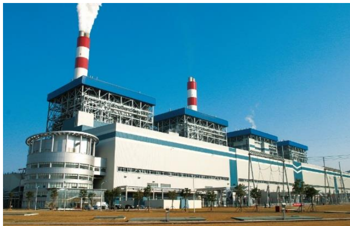
华能玉环电厂4×1000MW机组
