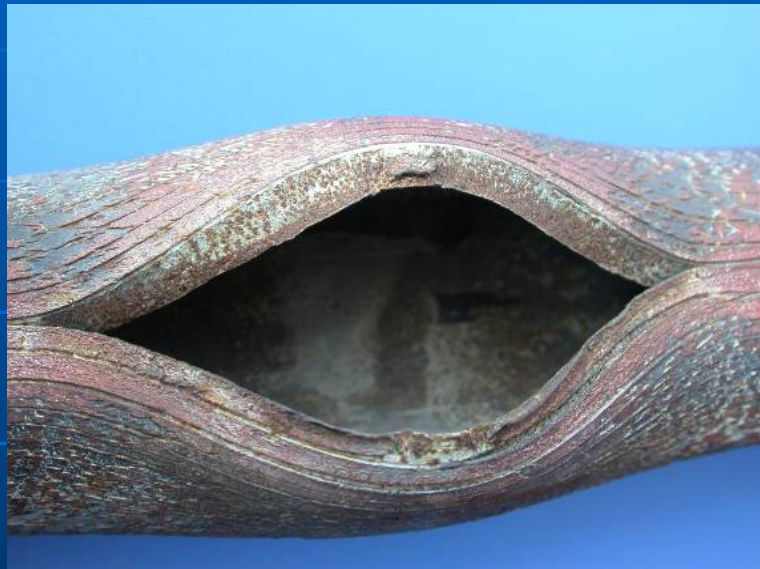
高温过热器 T23材料氧化皮脱落爆管宏观图
