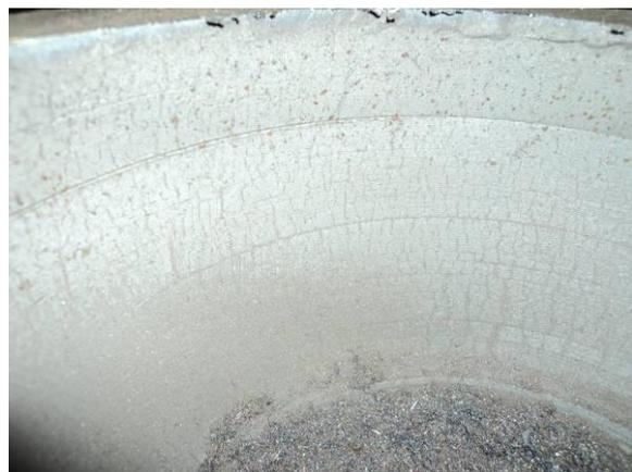
图 4：疏水罐内部裂纹情况
