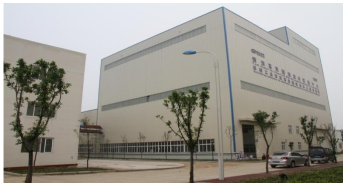
东方锅炉3MW清洁、高效燃烧试验中心
