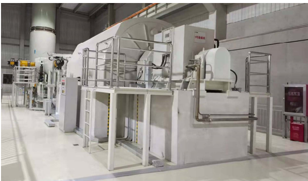
图 11 宽压力-变工况透平膨胀机
