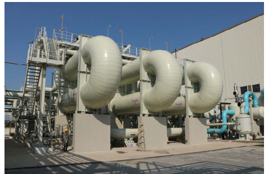
图 9 发夹式导热油-空气换热器
