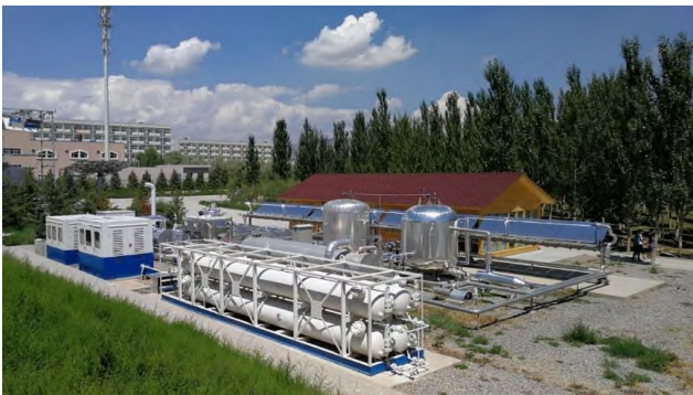
图4 青海西宁 100 kW 光热复合压缩空气储能工业试验电站
