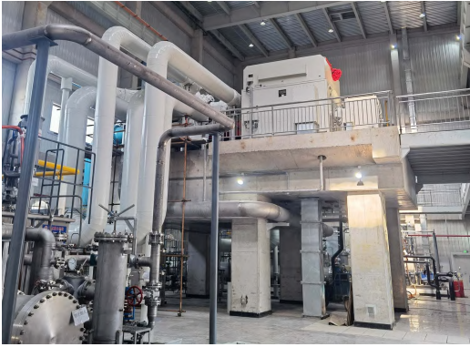
图 8 高负荷-宽工况非稳态离心压缩机
