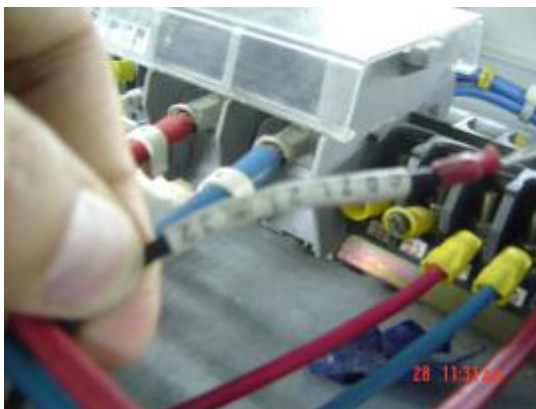
图10 机柜内接线
