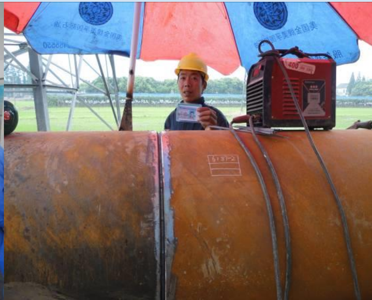
现场抽检焊工证
