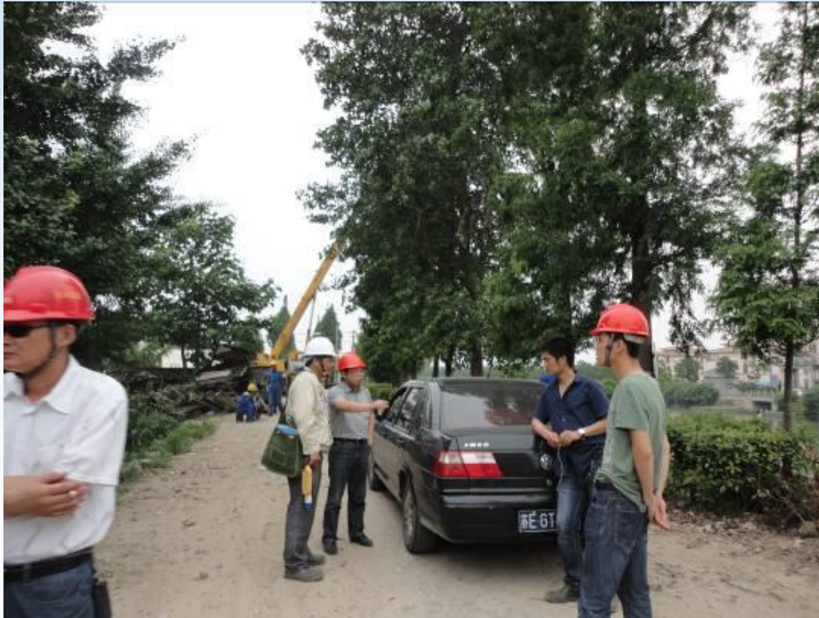
特检院承压室主任对现场焊接进行指导
