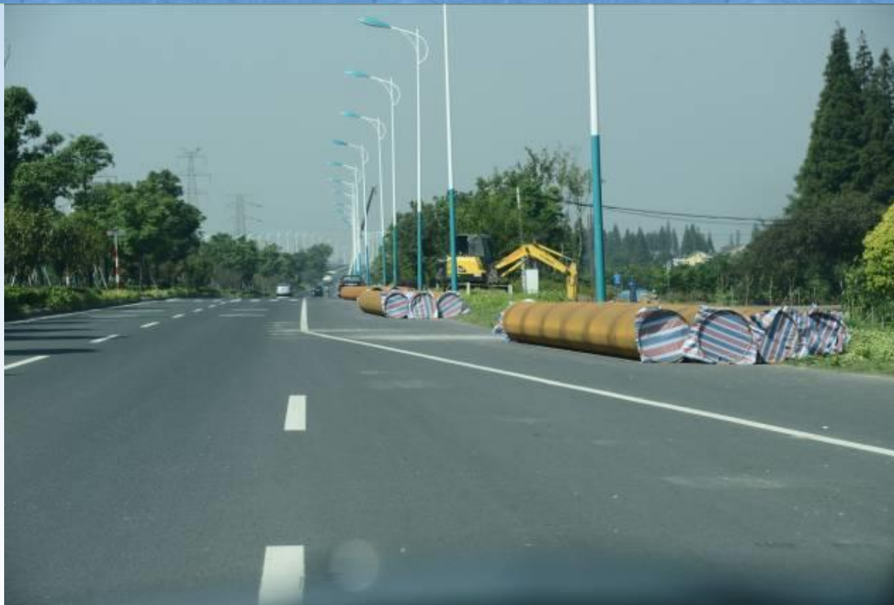
管道沿路堆放
