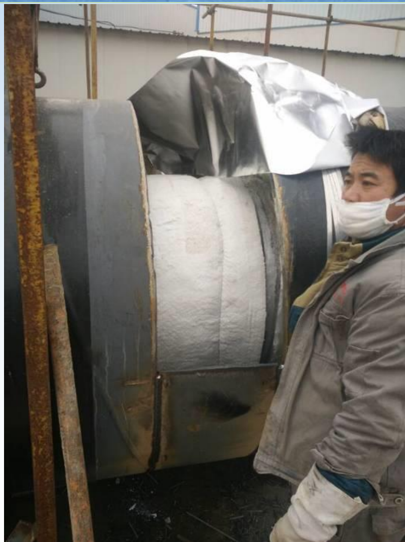
厂家外管道防腐
