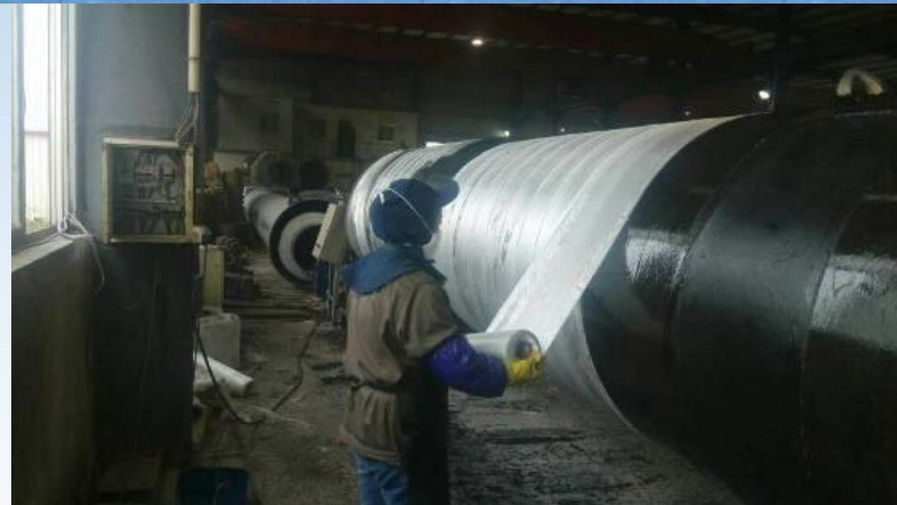
厂家外管道防腐
