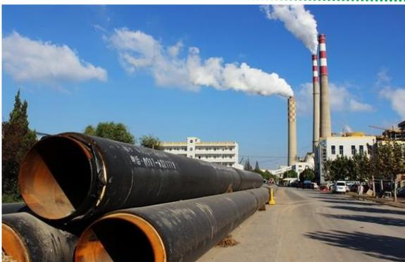
公司先后完成1、2、4号机组供热改造，最大供热能力320吨/小时，取代小锅炉、小热电向市区供热，实现降低发电煤耗7克/千瓦时，充分发挥了大机组高效、环保的优势，有效提升了地方节能减排水平。
