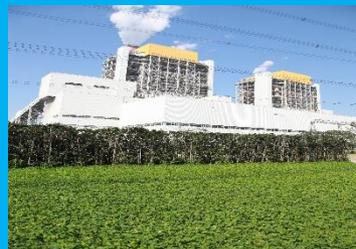
作为华润电力的第一个百万机组项目，铜山华润电力2台百万机组投产后运行稳定。2014年全年累计发电量112.577亿千瓦时，负荷率79%，供电煤耗291.08克/千瓦时；2015年全年累计发电量119.42亿千瓦时，负荷率80.97%，供电煤耗285.07克/千瓦时。
