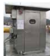
分析小屋 集成取样探头、在线色谱仪、硫化氢&总硫分析仪、水露点分析仪和烃露点分析仪、标气载气瓶组合预处理系统等 防爆等级不低于EExd IIB T4
