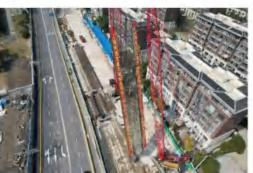
目前进度:1月13日,沪通铁路的重要配套工程迎来新进展。在上海市浦东新区惠南镇塘路村上海东动车运用所建设现场,随着六线检修库主库钢结构最后一榀桁架安装完成,标志着上海东动车运用所六线检修库主体结构完工。
